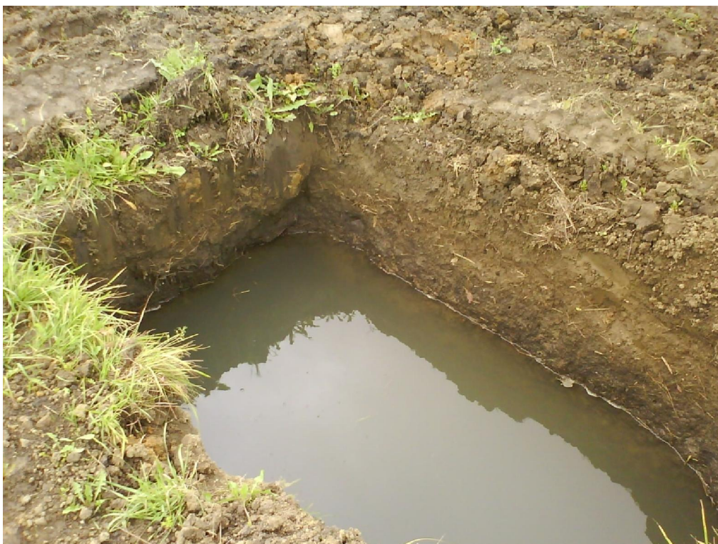
Foto 3. Šarišské Sokolovce. Výkop na pripojenie telekomunikačného stožiaru medzi kótami 493,6 a 465,7.
