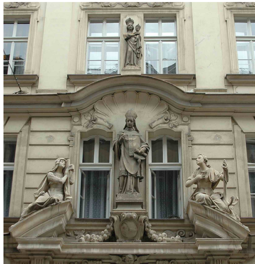
22. Výzdoba průčelí koleje Arnošta z Pardubic, 1902, štuk, nadživotní velikost, Praha, Voršilská ulice.
