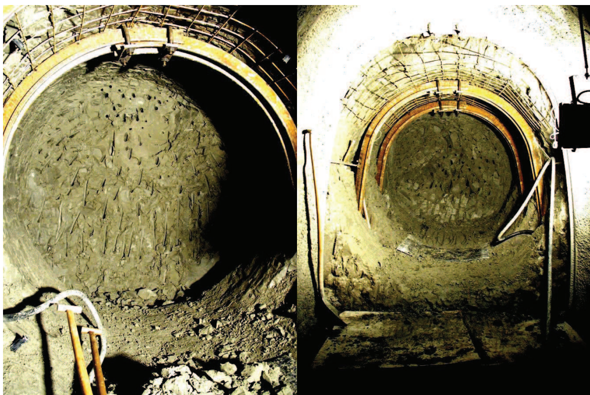
Obr. 3.2. Rozrážka ve staničení 5 m před budoucí zákrutou (vlevo) a ve staničení 2,5 m (vpravo) (Pavlík a kol. 2003).
