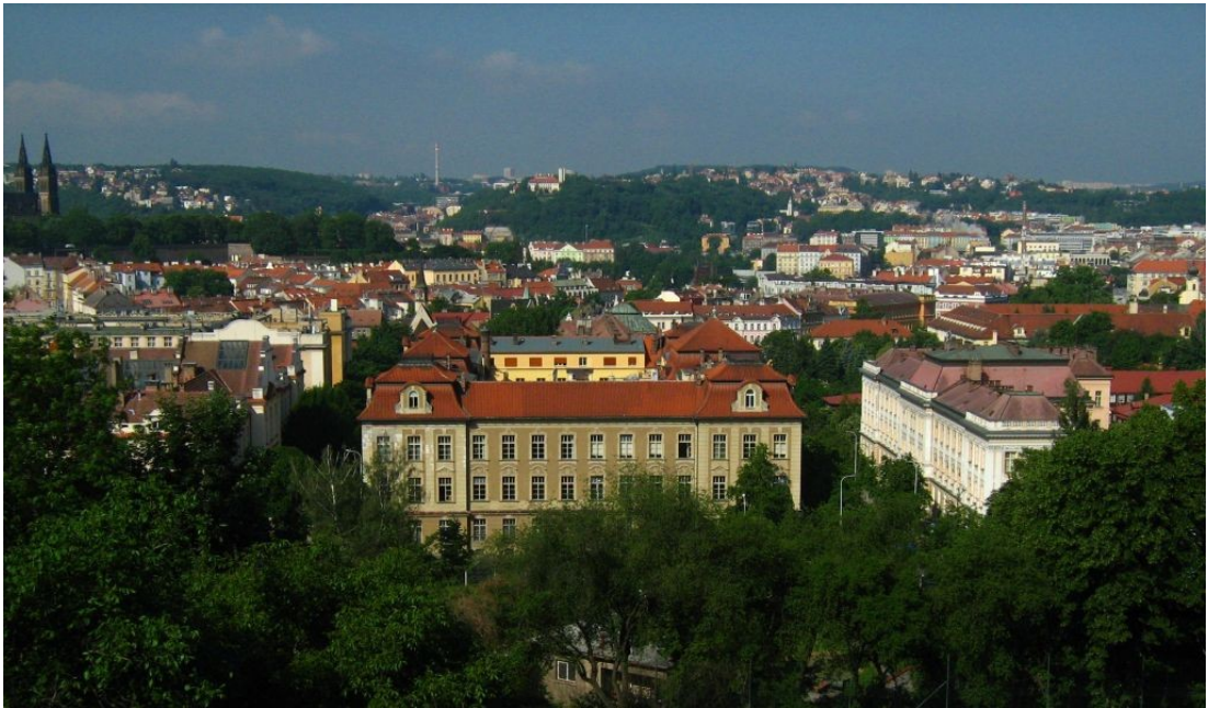
Budova Albertov 6: pohled z východu
