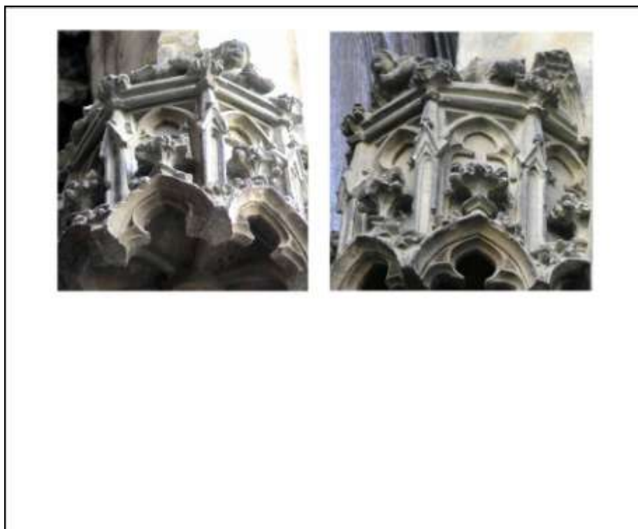
6. Detail baldachýnu nad soškou anděla ze Zvěstování. Foto: autor
