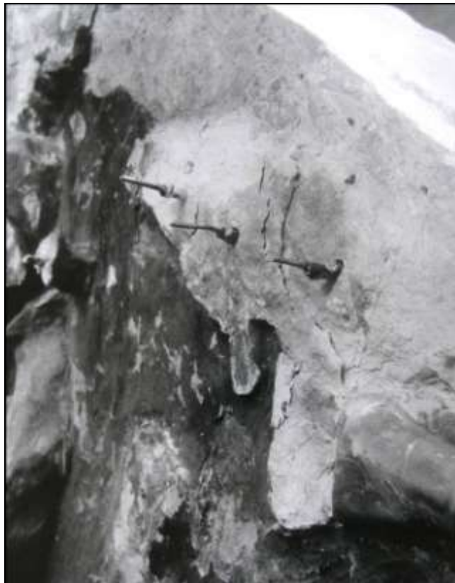
38. Detail uchycení originálu reliéfu tympanonu.
