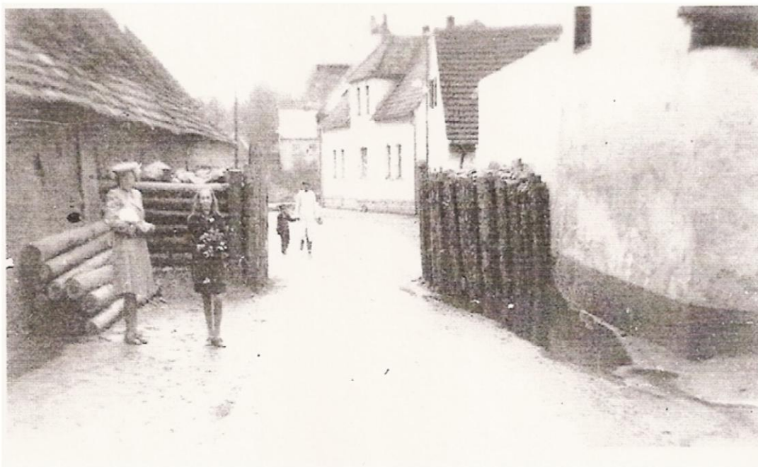
Příloha č. 8: Protitankové zátarasy v obci Vejprnice (Soukromý archiv pana Františka Filipa)
