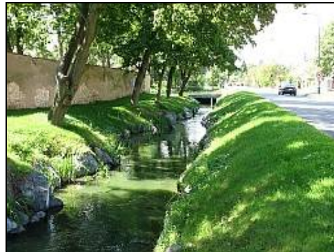
d) stav po revitalizaci, srpen 2010
