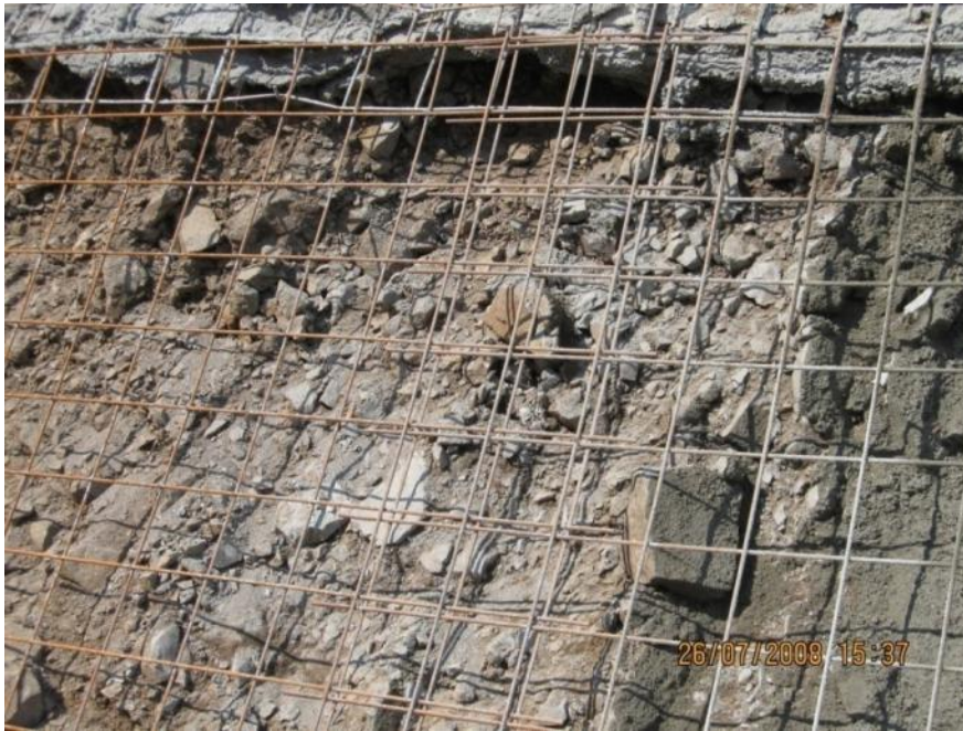
Obr.9 Zvětralé tufy a bazalty zastižené při hloubení portálu (Barták a Čejka, 2010)
