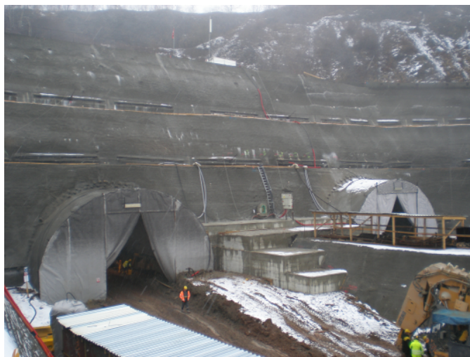
Obr.11 Mikropilotový deštník (Hilar et al., 2010)
