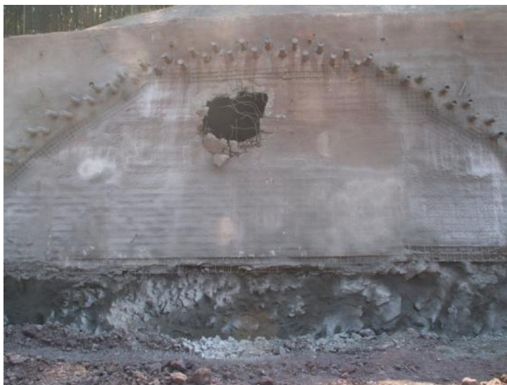
Obr.14 Proražení pravé tunelové trouby v místech ústeckého portálu (Bým, 2009)
