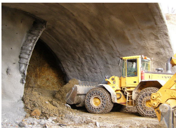
Obr.4 Členěná kalota prackovického tunelu (Hilar et al., 2010)
