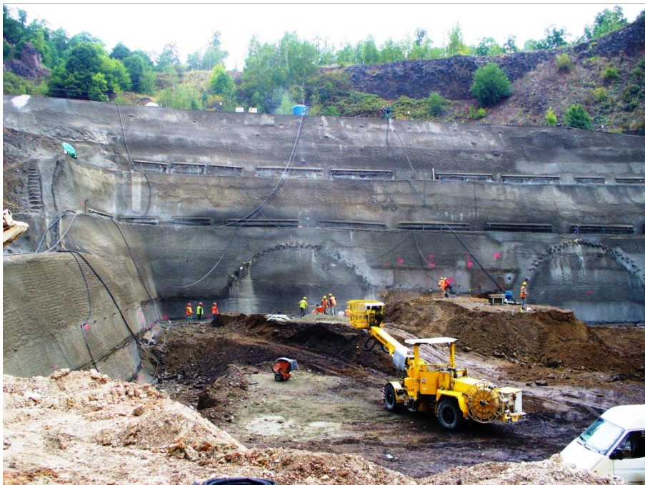
Obr.10 Oblast pražského portálu před zahájením ražby (Barták a Čejka, 2010)
