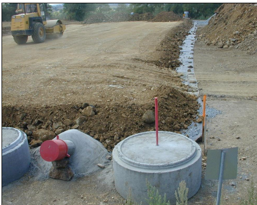
(obr.5 – fotografie zhotoveného zhlaví, dle Instruktažní příručka SG – Geotechnika a.s.)
