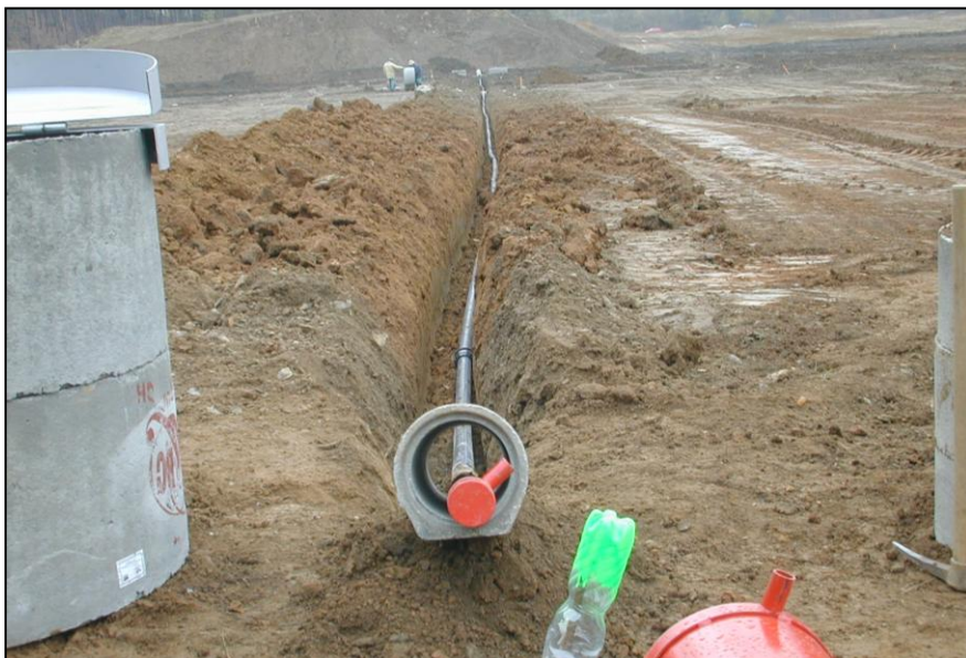
(obr.4 – fotografie při instalaci měřícího profilu, dle Instruktažní příručka SG – Geotechnika a.s.)
