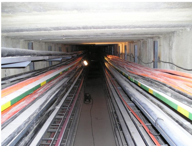
Obr. 4 Kabelový prostor s azbestocementovými deskami
