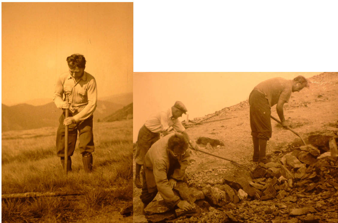
Obrázek 8, 9: Instalace tyčového značení a oprava turistických cest 121
