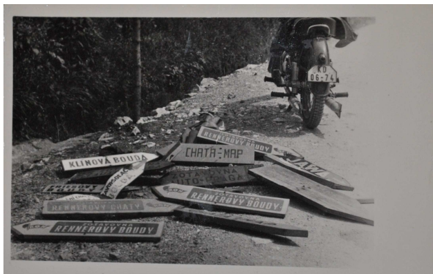
Obrázek 11: Odstraňování značek nevyhovujících vyhlášce 123
