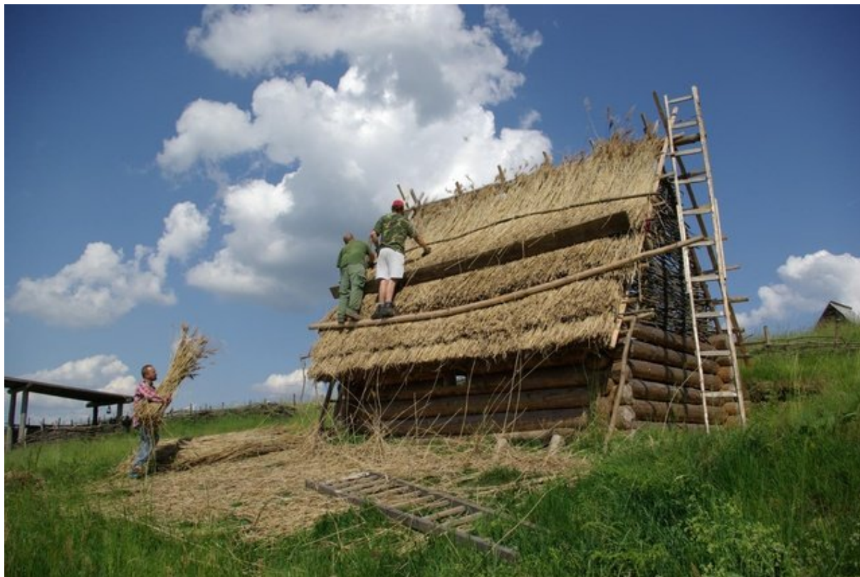
CURIA VÍTKOV – stavba domu řemeslníka
