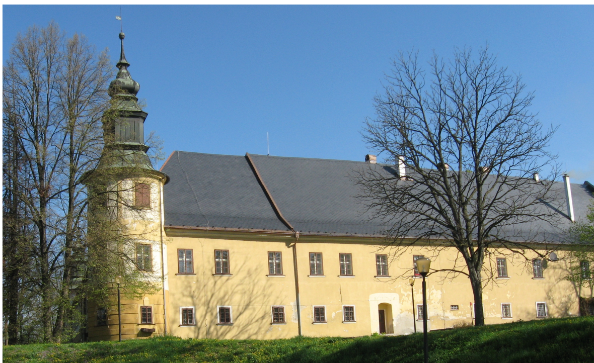
Obr. 18: Jižní křídlo zámku. Foto autorka.
