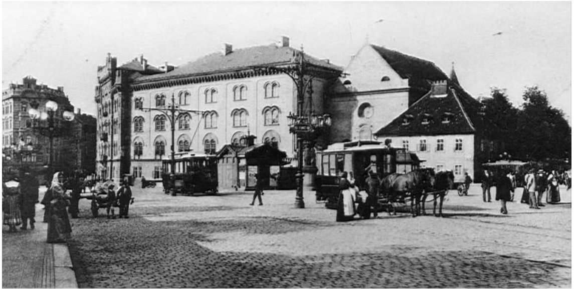
Příloha č. 6: Koňská a elektrická dráha na Josefském náměstí Archiv DP Praha, Sbirka fotografií, inv. č. není.
