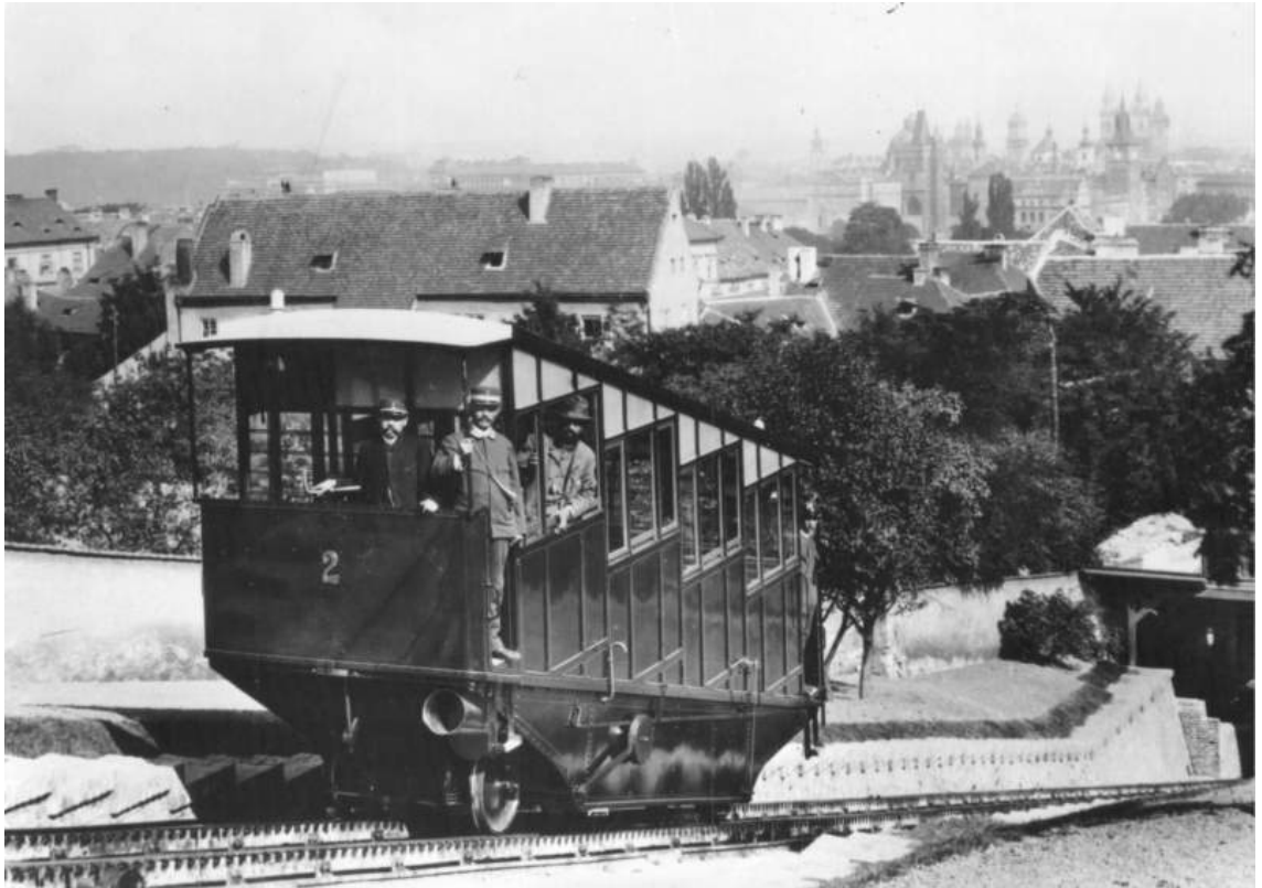
Příloha č. 4: Lanovka na Petřín Archiv DP Praha, Sběrka fotografií, inv. č. není.
