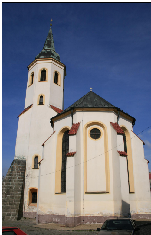
34. Ostrov, kostel sv. Michaela přelom 13–14. století, pohled od východu na presbyterium
