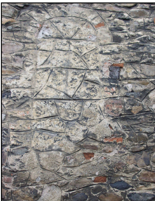
22. Ostrov, kostel sv. Jakuba Většího, 3. desetiletí 13. století, detail zdiva severní stěny kostela
