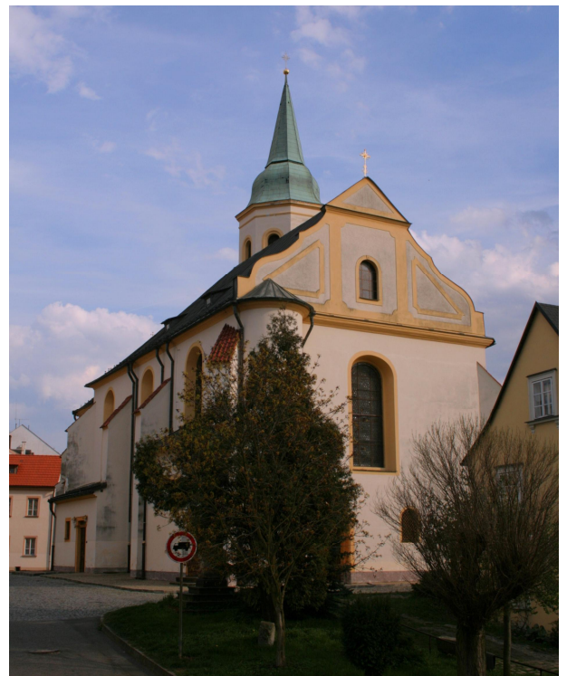
42. Ostrov, kostel sv. Michaela, přelom 13–14. století, pohled na barokní západní štít, zbudovaný v letech 1607–1609
