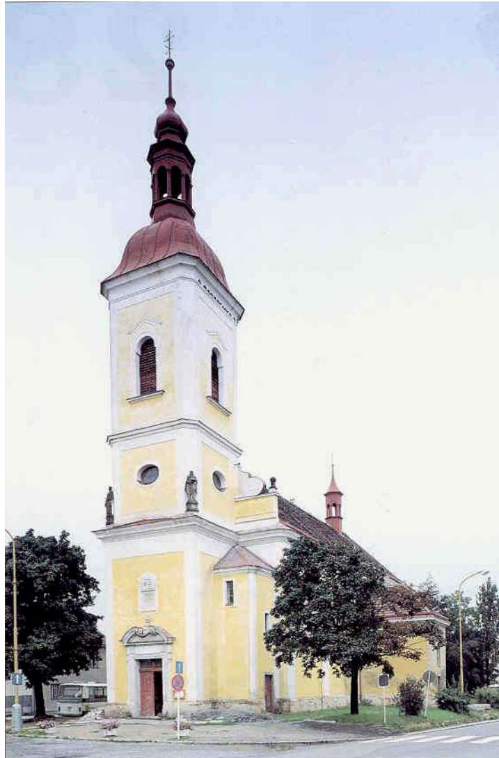
14. Kostel sv. Petra a Pavla, oprava fasády 1983–1984. Pohled od jihozápadu
