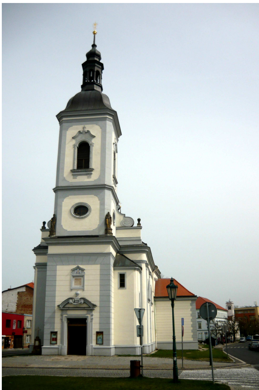
1. Kostel sv. Petra a Pavla v Říčanech, jižní zdivo 3. čtvrtina 13. století, jižní věž 2. polovina 14. století, loď a sakristie 1719, západní dostavba lodi a věže 1900, pohled ze západu
