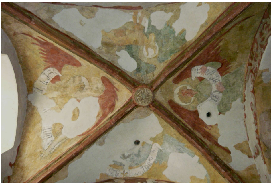
25. Klenba přízemí jižní věže, kolem roku 1400
