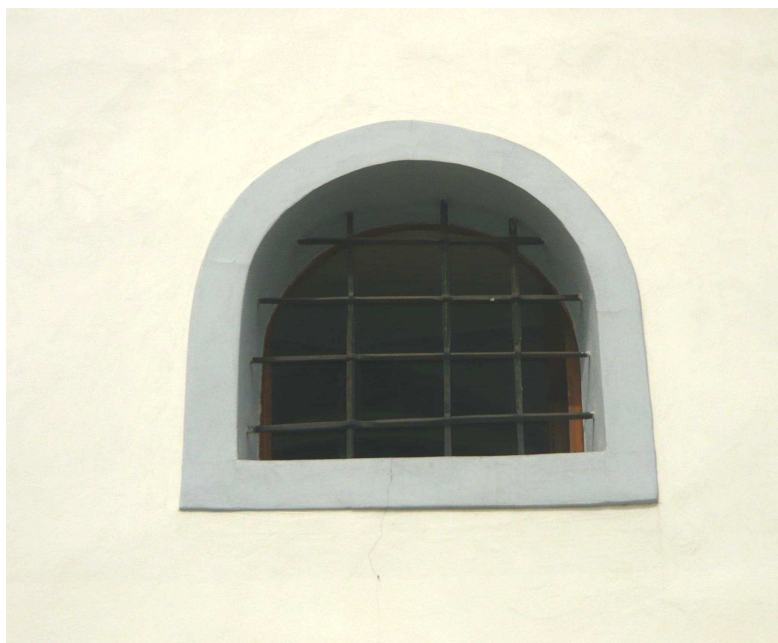
4. Jižní okno pod oratoří s mříží, 4. čtvrtina 16. století, pohled z jihu
