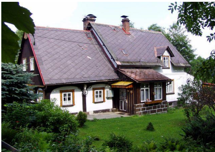
Břidlicová střecha: Krásné pole čp. 20, okres Děčín ( www.ceskesvycarsko.cz [2010-6-17])
