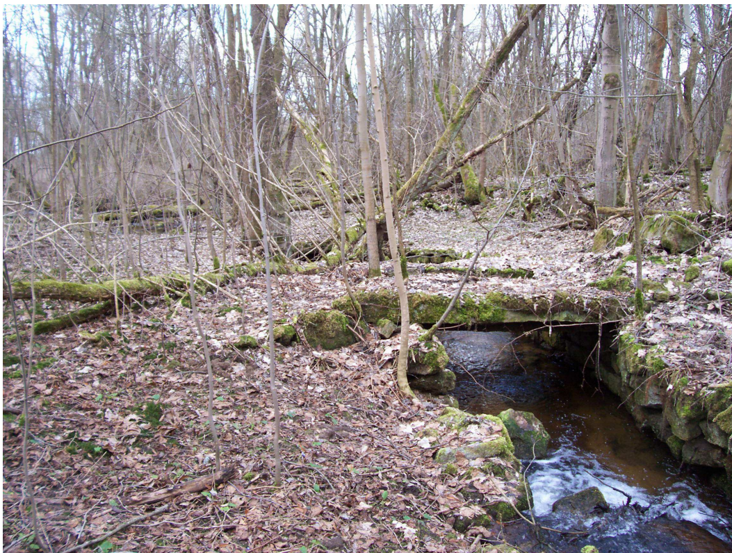
Obr. 17: Zachovalé můstky přes potok Pstruhovec. I díky nim lze mapovat původní stavení.
