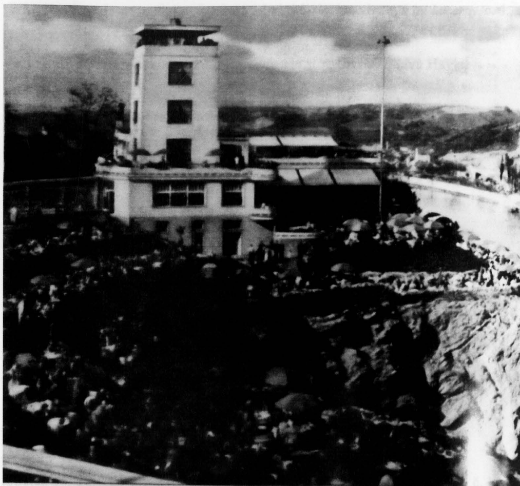
Barrandovské Terasy po dokončení.
