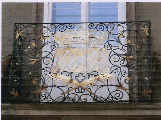
220 – Lázeňská 9, Malá Strana, balkón, 2.čtvrtina 18. století
