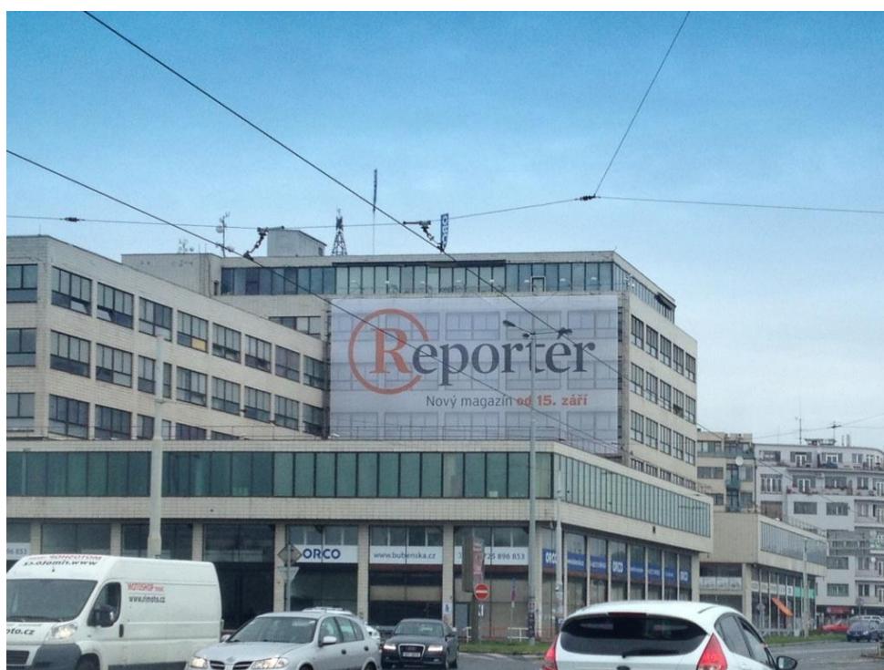
Obrázek 1: Plachta v blízkosti metra Vltavská
