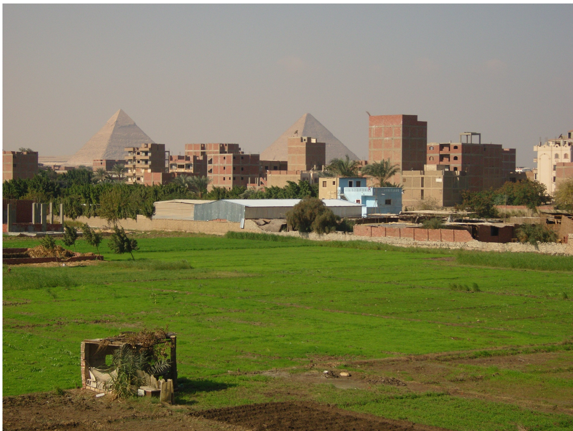
Obr. 1: Neoficiální zástavba na zemědělské půdě s betonovou konstrukcí a cihlovou výplní. Na budově vpravo je vidět základ pro přistavení další místnosti. Gíza, oblast al-Haram
