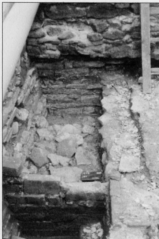
Obr. 5. Stará Boleslav 1998. Bazilika sv. Václava, sonda 4. Detail provázaného zdiva západní stěny Vrábšské kaple a severní obvodové zdi baziliky. Počáteční fáze odkryvu v pohledu od severu. V popředí zdivo gotické pece, za níž jedna z úrovní zádlažby. Vlevo nahoře dodatečná zazdívka proraženého otvoru s druhotně užitými sloupky z pískovce, vpravo nahoře část mladší úpravy líce severní lodi.
