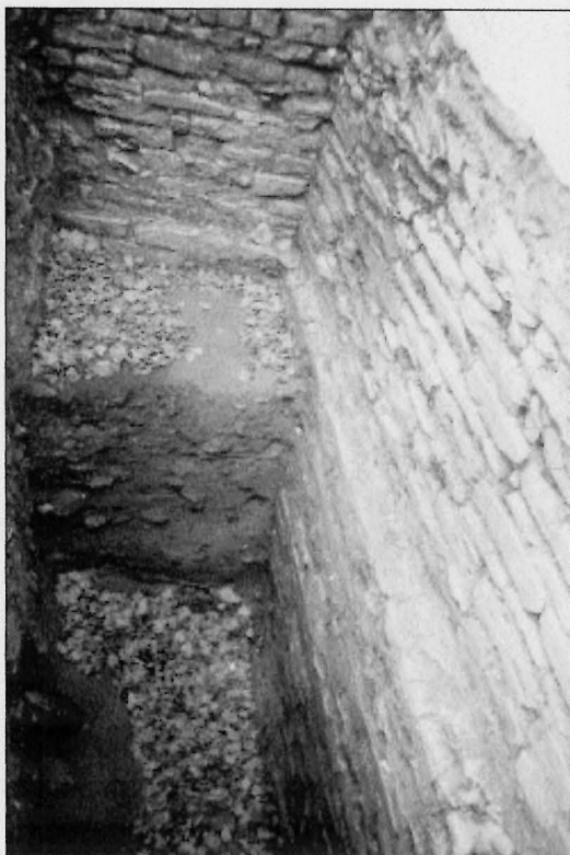
Obr. 4. Stará Boleslav 1997. Bazilika sv. Václava, sonda 1. Detail zdiva severovýchodního nároží Vrábšské kaple provázané s náběhem severní apsidy.
