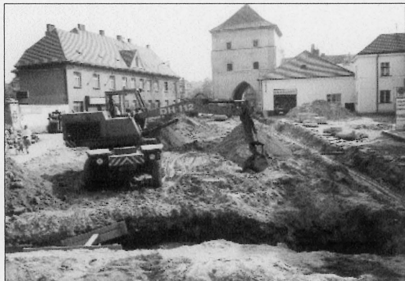
Obr. 8. Stará Boleslav 1995. Situace při rekonstrukci plochy Svatováclavského nám. Foto od západu.
