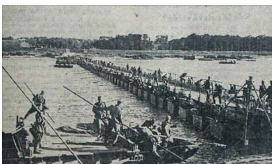
Při přechodu přes Vislu, vyznamenaly se ženijní jednotky říšské branné moci, které vidíte při stavbě pontonového mostu
