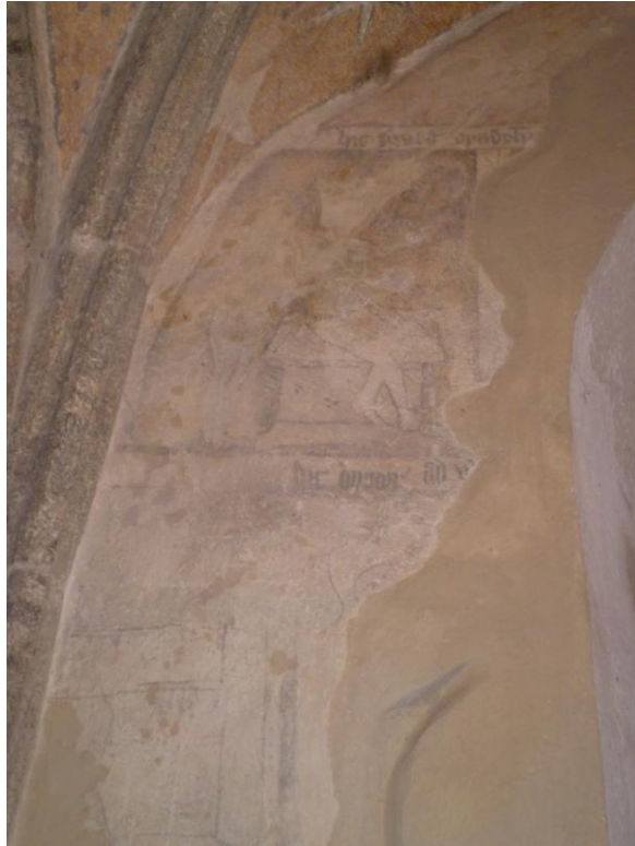
75 Malby na severní stěně kaple, kostel sv. Jana Křtitele v Českém Rudolci, po polovině 14. století, severní stěna kaple.
