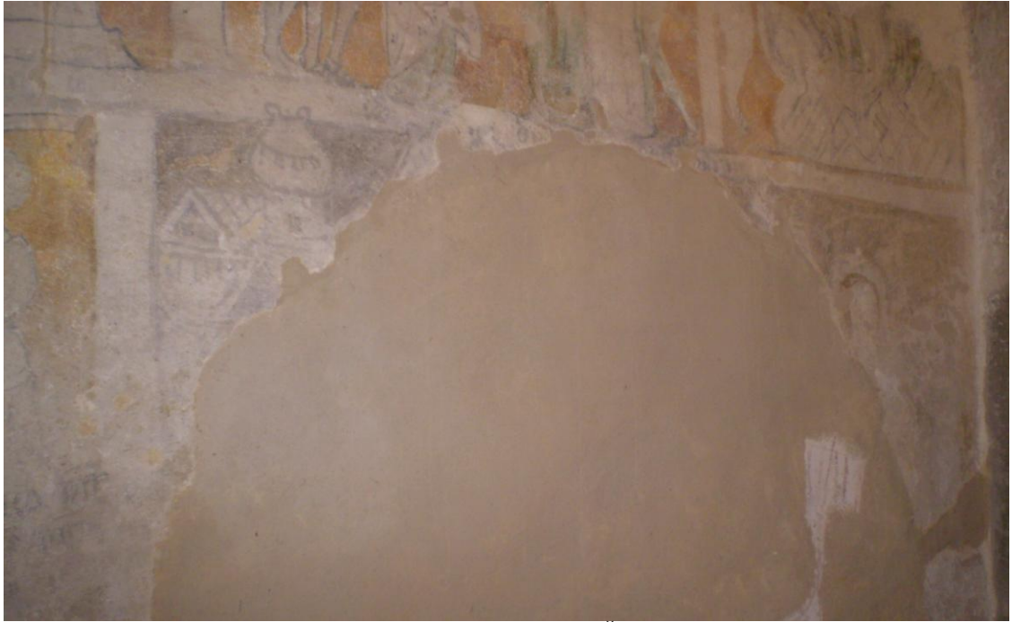
43 Fragment stavby, nástěnná malba v kostele sv. Jana Křtitele v Českém Rudolci, po polovině 14. století, jižní stěna kaple.
