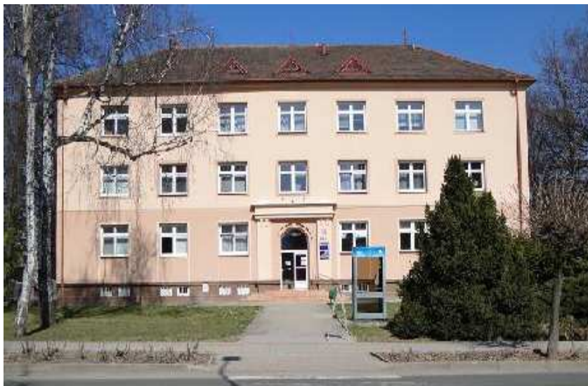
Obr. 43: Budova bývalé polikliniky a lékárny na ulici Svitavská 25 (zdroj: foto autorka březen 2011)
