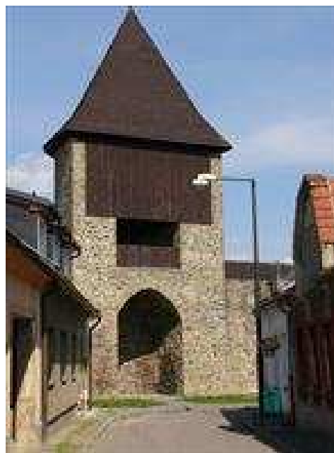
Obr. 20: Gotické opevnění (zdroj: http://www.policka.org/detail/81/o-meste/pamatky/Goticke-opevneni/ [cit. 2011-03-11])
