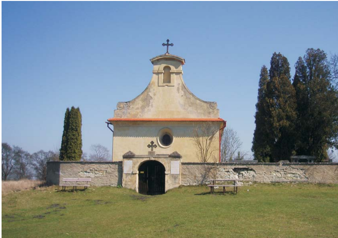
Příloha č. 1 - Kostel sv. Jiří - průčelí (vlastní foto, 2008)
