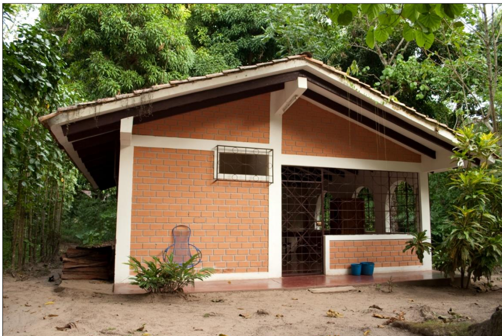
Obr. č. 6: Pohled na samotku vybavenou vlastním sociálním zařízením.
