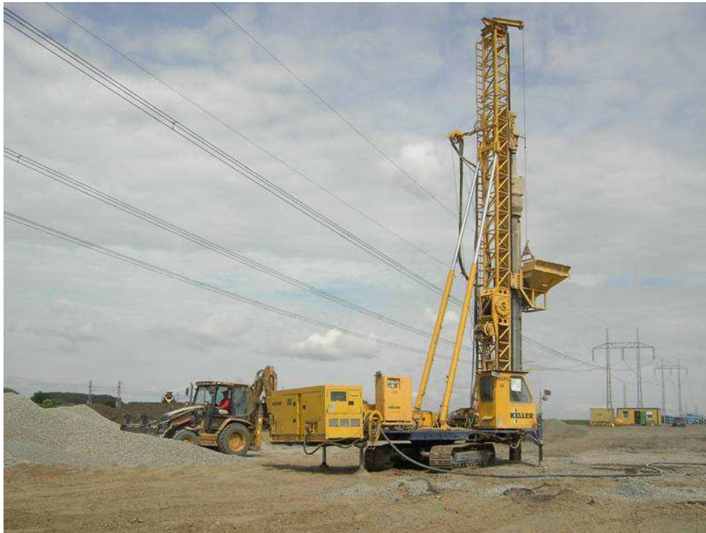
Obrázek 27: Metoda s dolním plněním bez vodního výplachu. Stroje společnosti KELLER
