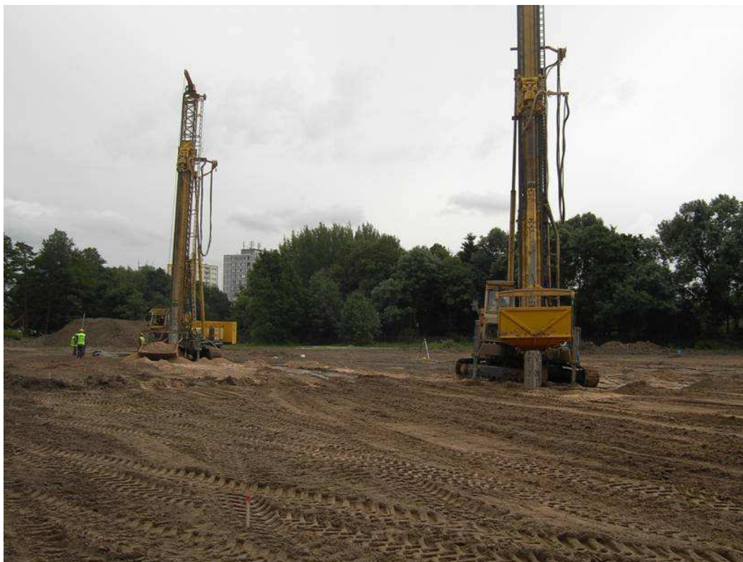
Obrázek 36: Na stavbě byly nasazeny dvě soupravy společnosti KELLER
