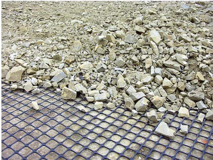
Obrázek 4: „Zazubení“ zásypového kameniva do geomříže (Geomat, s.r.o.)
