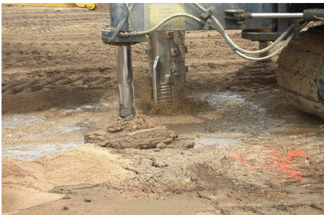
Obrázek 37: Provádění vibroflotace v místech založení bazénů. Na obrázku je vidět zapuštění vibrační jehly.
