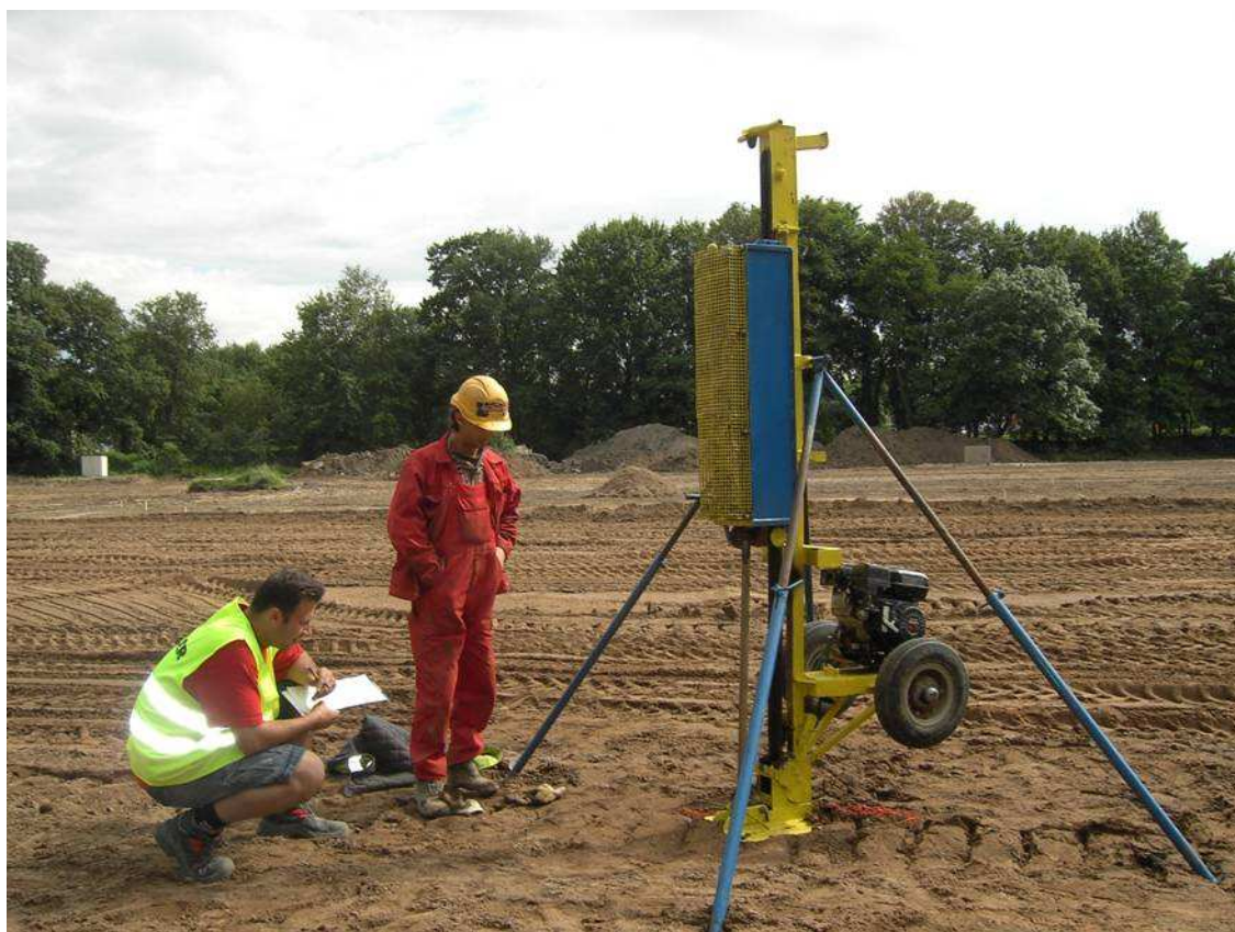
Obrázek 38: Zkoušky dynamické penetrace během stavby
