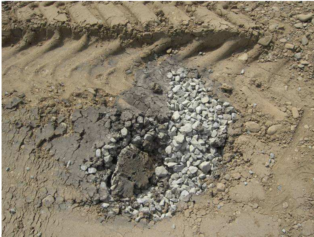
Obrázek 29: Zhotovený štěrkový pilíř
