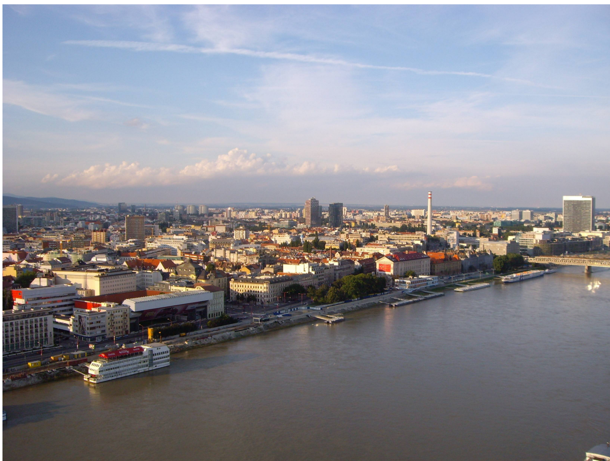
Obr. 14 Pohled z Nového mostu na levobřežní část města. Vlevo nelze přehlédnout přemostění SNG architekta Dědečka. Vidět je i probíhající stavba protipovodňových bariér.
