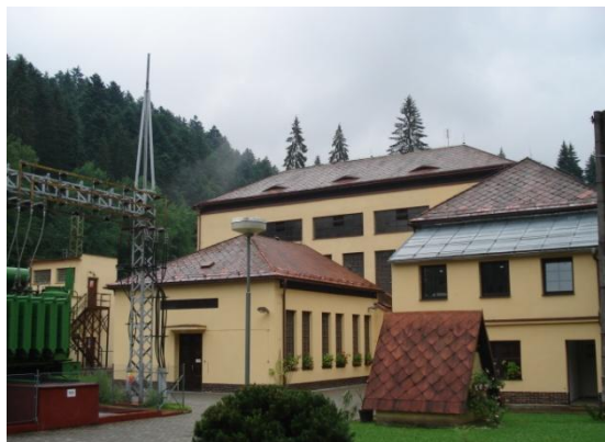
Obr. 13: Vodní elektrárna Vydra (POÚ Kašperské Hory)
