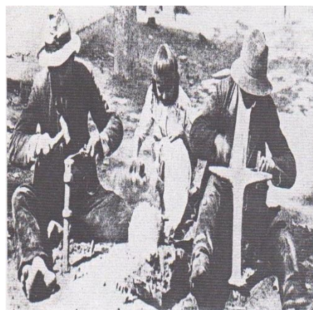
Romští kováři dříve pracovali vsedě, na jednoduché kovadlině, zabodnuté do země
