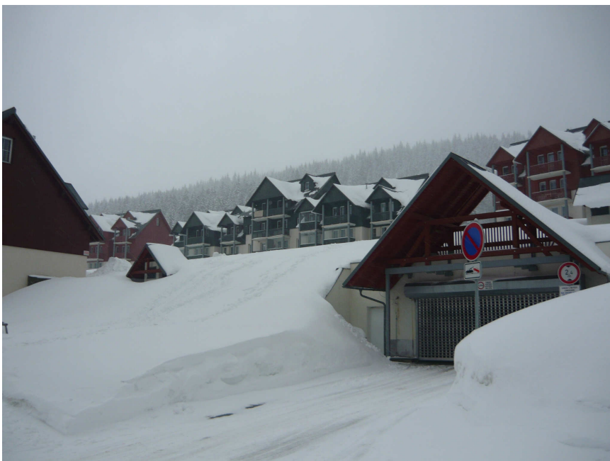
Obr. 23: Součástí bytových komplexů na Horních Mísečkách jsou také dvoupatrové podzemní garáže pro 300 aut
