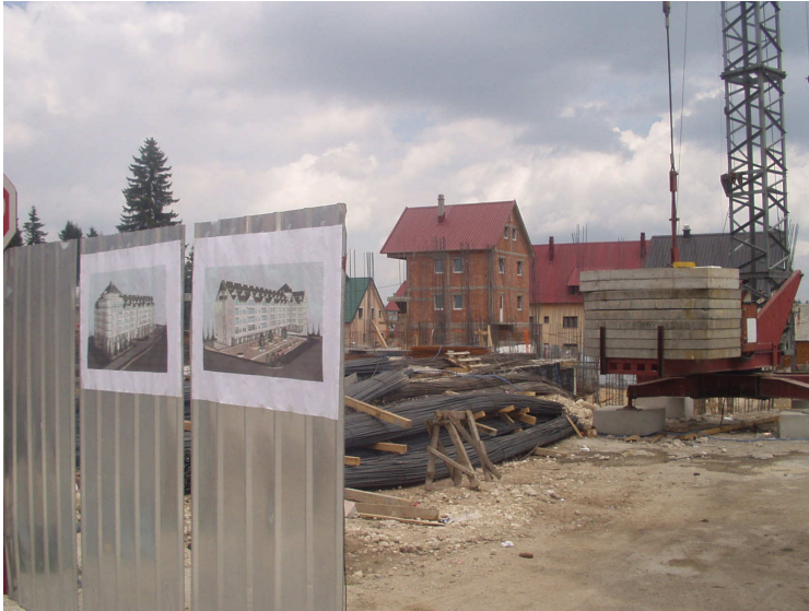
Obr. 24: Stavba rekreačních bytů v podhorské obci Žabljak, která je výchozím místem do pohoří Durmitor. V Černé Hoře se bezhlavě staví, přestože zdroje vody nestačí ani pro stávající objekty. Foto: autorka 19. 7. 2008, Žabljak, Černá Hora
