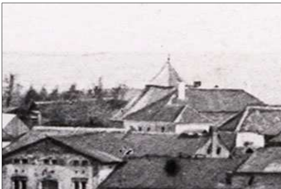
Obr. 9 Bartolomějská šachta. Detail fotografie z roku 1883 (Rambousek, 2007).
