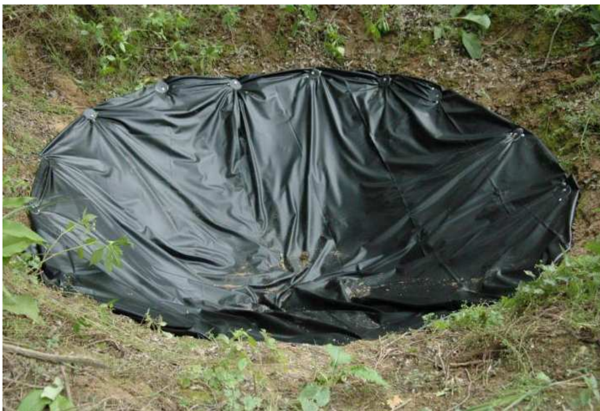
Obrázek I – 3: Přeměna tůní z periodické do permanentní podoby. Kvůli nepropustnosti dna instalována hydroizolační fólie (Hobyfol). Červenec 2007.
