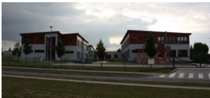
Obr. 8: ZŠ Kunratice po rekonstrukci
