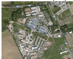
Zástavba skladových prostor
