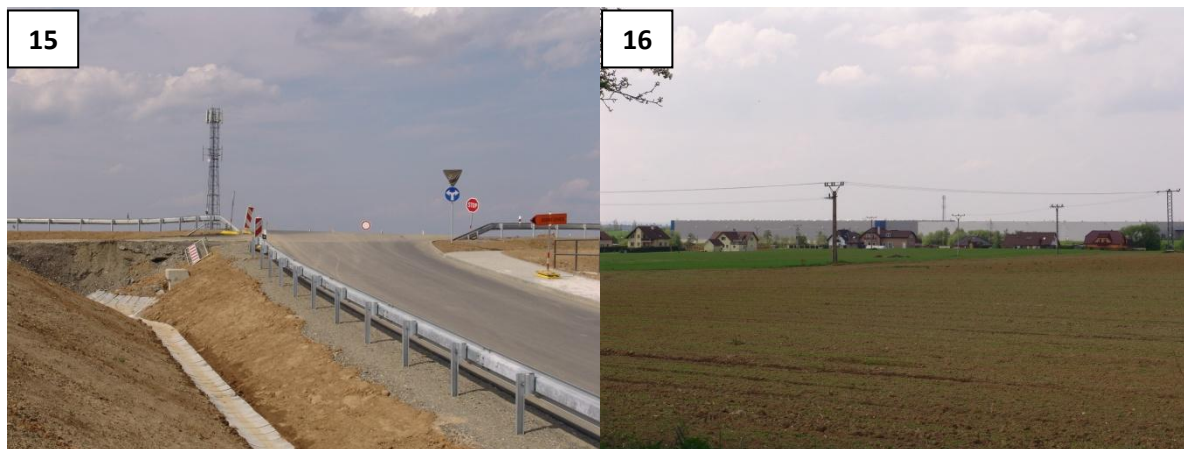
Obr. 15: Čistě účelové komunikace bez jakéhokoli zázemí, Modletice
