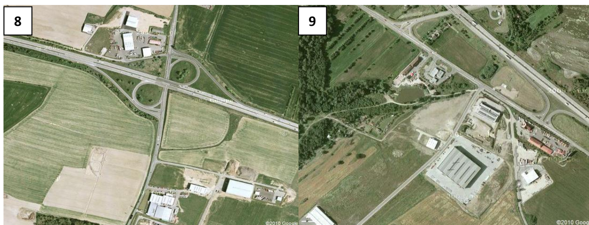
Obr. 8: Křížení D1 se silnicí 399 směr Náměšť nad Oslavou jižně od Velké Bíteše
