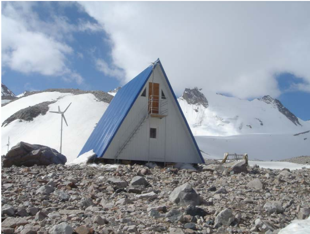
Obr. 20: Výzkumná stanice na břehu jezera Adygine.
