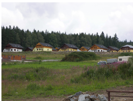
Obr. 7 Villapark Lipno Resort, 20 objektů, obec Lipno n. Vltavou
