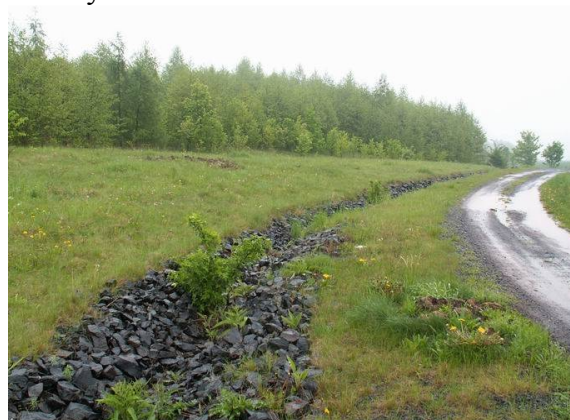
Příloha 12: Odvodňovací příkopy poblíž lokality A1.
