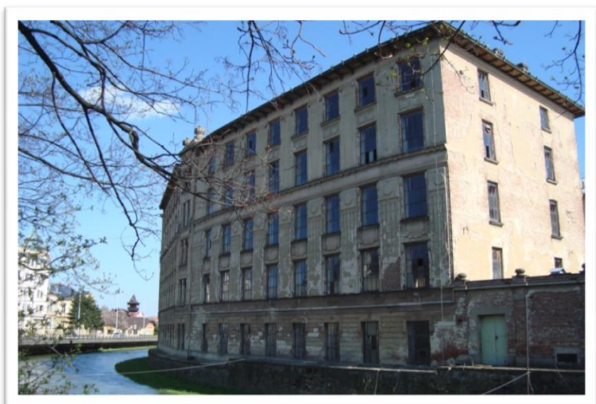
Pohled na objekt z ulice Svatováclavská
