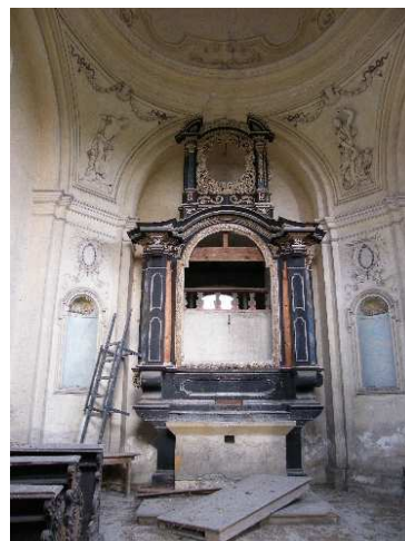
9. Liběšice, interiér kaple sv. Františka Xaverského
