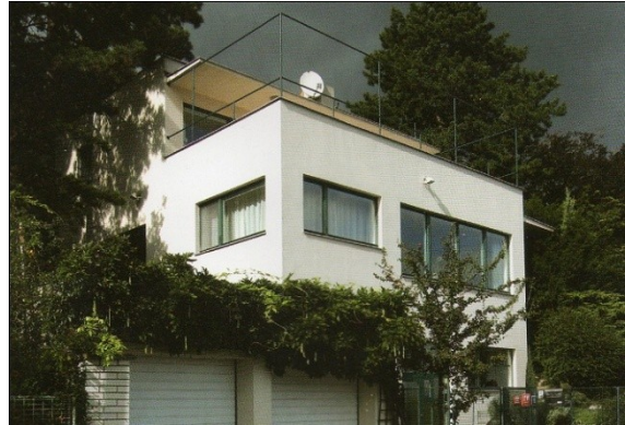
foto č.25, vlastní vila arch.Janáka (Praha 6)
