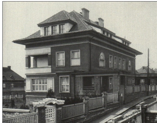
foto č.14, dvojdům bratří Čapků , (arch.L.Machoň Praha10)
