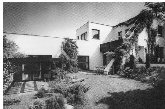
foto č.35, vila V.Chytilové (arch. Příkryl, Praha 7)
