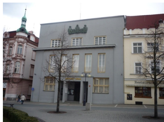
foto č.6 Městská spořitelna (arch.Novotný, Benešov)
