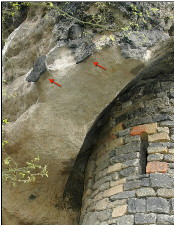
Obr. 19, 20 – Solné skalní kůry nad schodištěm východního masivu.
