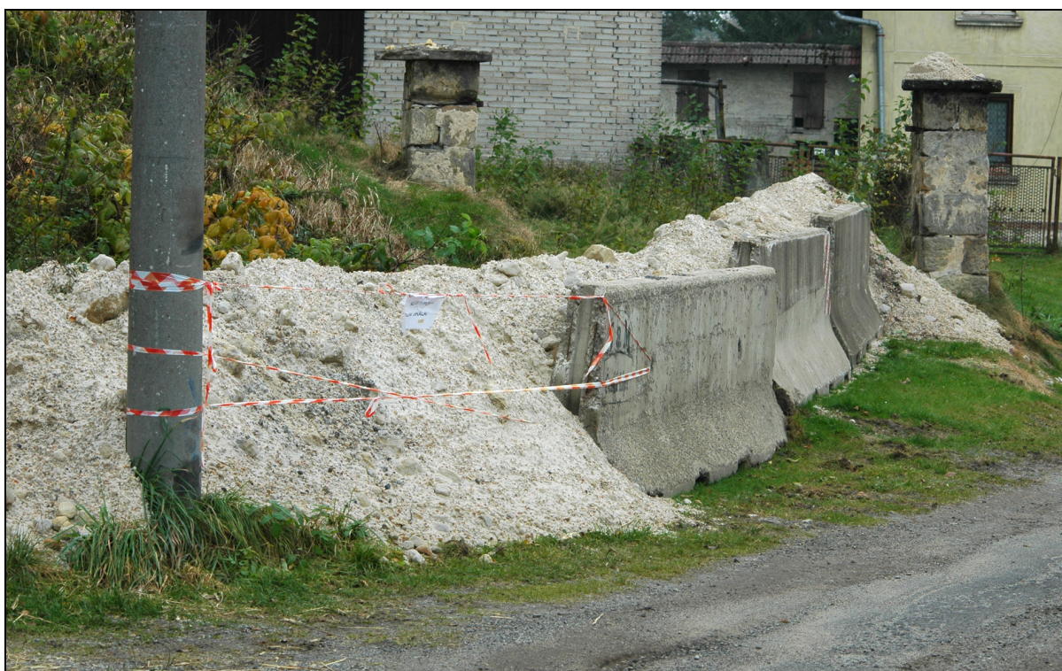
Foto 34 – Provizorní bariéry vybudované na úpatí kopce. Po sanaci dne 31. 10. 2009 byly odstraněny.
