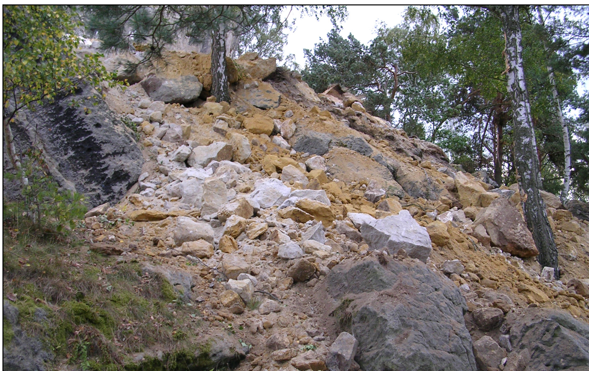
Foto 16 – Vrchní část jihozápadního svahu. V této části se zastavily převážně střední a velké balvany. Světle šedý pískovec v přední části akumulace pochází z dřívě zříceného balvanu.
