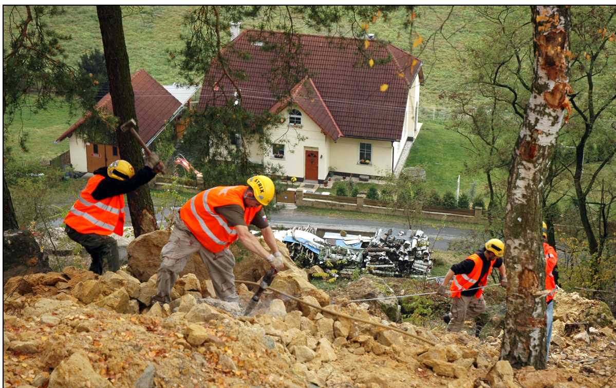
Foto 35 – Rozbíjení balvanů při sanaci.
