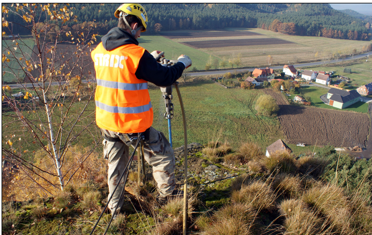
Foto 37 – Rozvolnění nestabilního bloku před jeho shozem. Foto J. Sochor.
