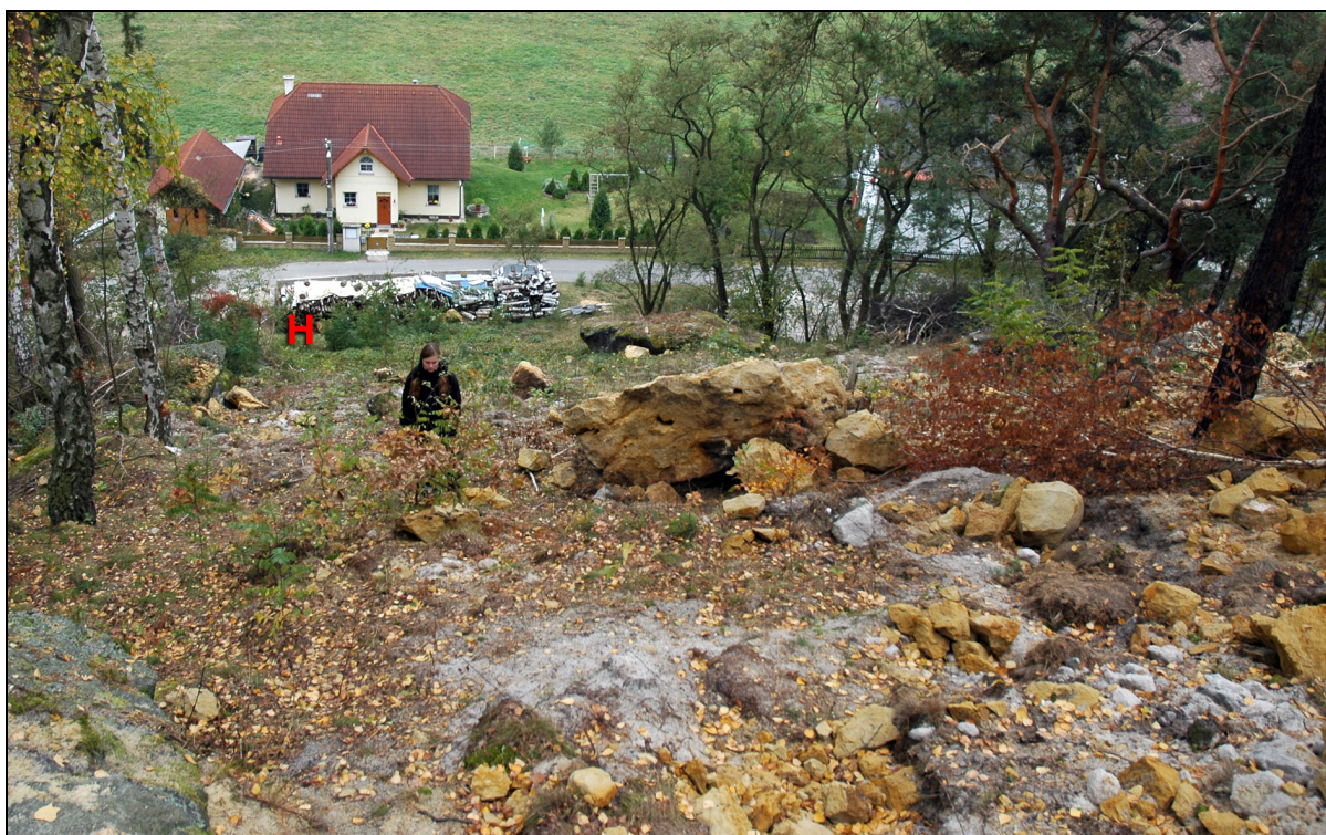
Foto 17 – Spodní část jihozápadního svahu. Několik větších balvanů se zastavilo až při úpatí svahu o bariéru naskládaného dřeva (H). Uprostřed svahu jeden z největších balvanů tohoto skalního řícení, s rozměry 2,5 x 1 x 1 m.
