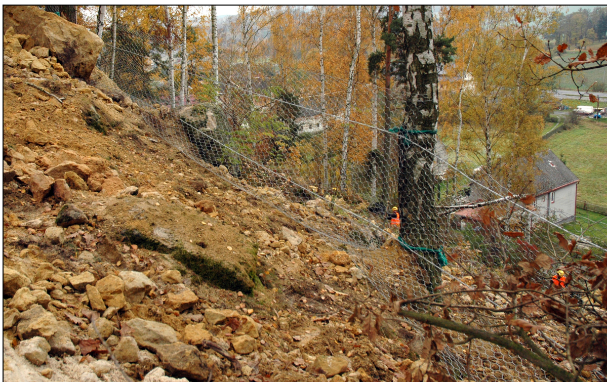
Foto 36 – Dočasně instalovaný zadržný plot.
