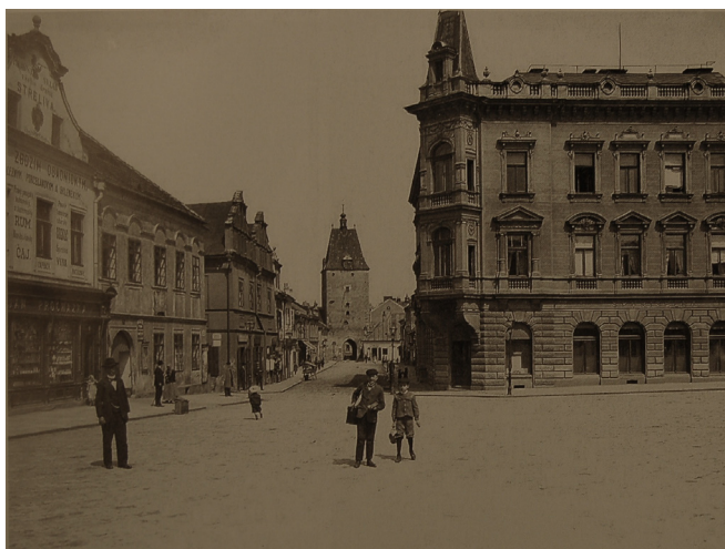
4. Novostavba spořitelny, kolem r 1900, východní strana náměstí.
