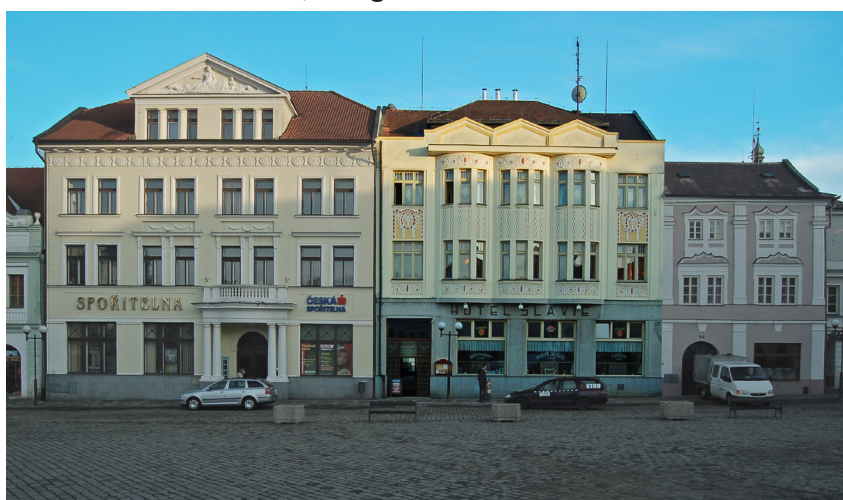
20. Hotel Rosol čp. 29, Jan Kotrnoch, 1912- 1913, zasazení v jižní straně náměstí.
