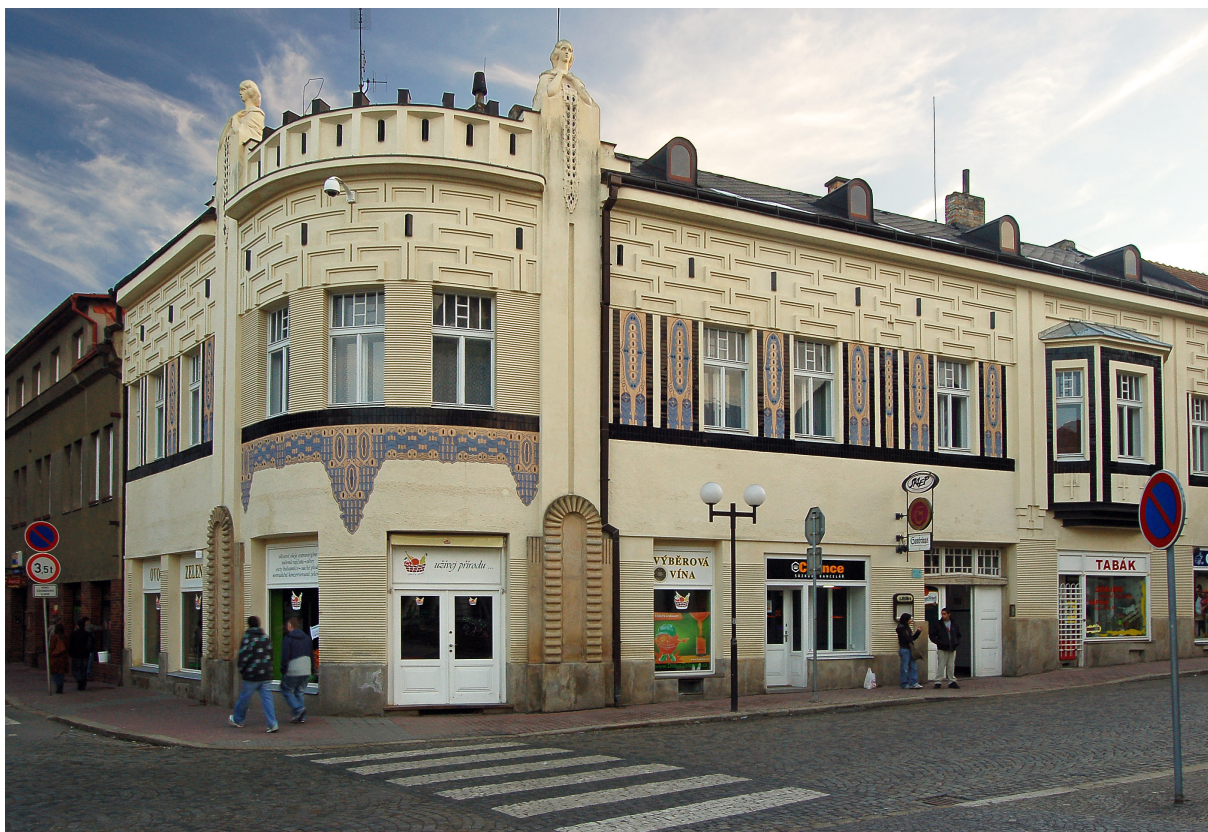
53. Dům čp. 836, Ladislav Novotný, 1911 - 1912, pohled od východu.
