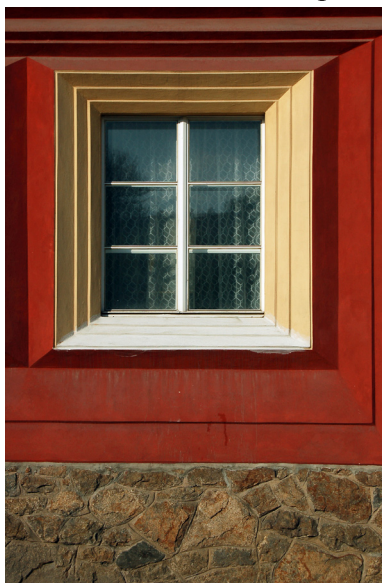
26. Drechselova vila, Pavel Janák, 1912 - 1913, detail okna.
