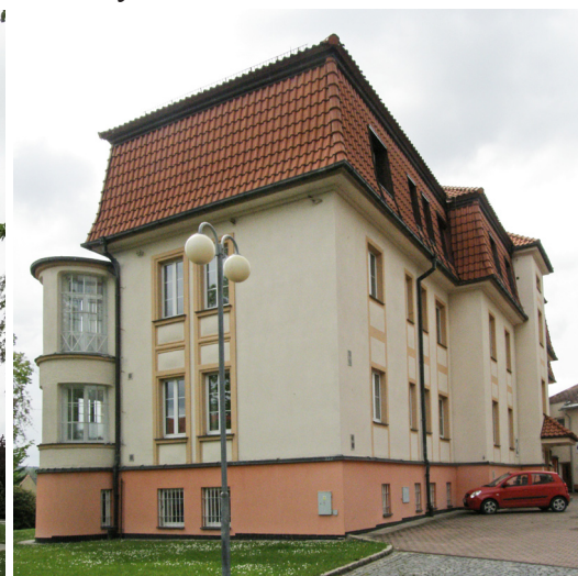
73. Vánova vila čp. 127, Jan Legát, 1923 - 1924, pohled na nárožní arkýř, od severozápadu.
