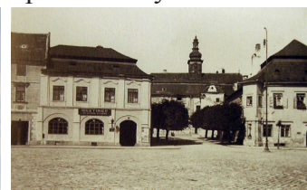
1. Dům U Zlatého soudku čp. 13, před rekonstrukcí.
