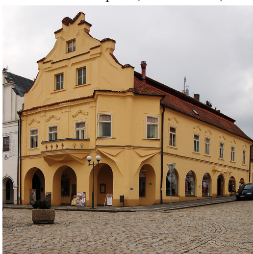
33. Fárův dům čp. 13, Pavel Janák, 1913 - 1914, pohled od severovýchodu.
