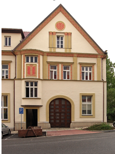
79. Obchodní dům Fleischl a Herrmannové, pohled na vjezdovou část.
