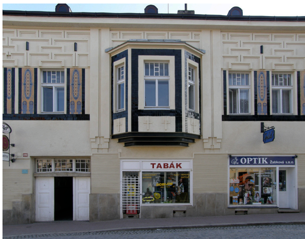
54. Dům čp. 836, Ladislav Novotný, 1911 - 1912, pohled na arkýř.
