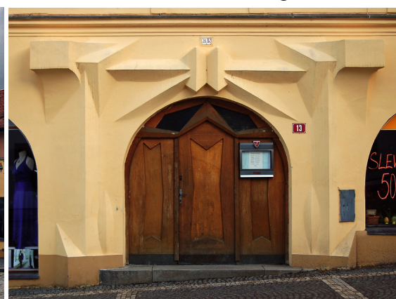
37. Fárův dům čp. 13, Pavel Janák, 1913 - 1914, detail portálu.
