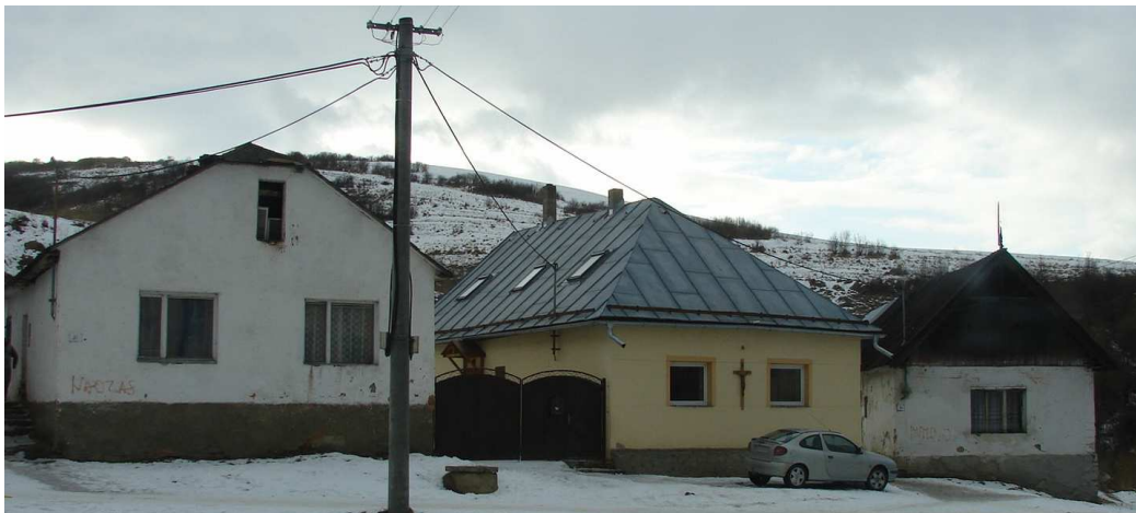
Základná škola, v pozadí veža evanjelického kostola
