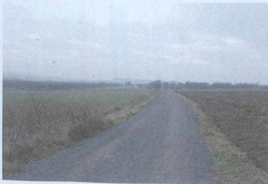
Obr. 5. Příjezdová cesta ke stanici
