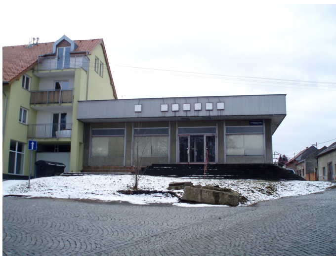
Obr. 20: Zrušená prodejna v Malenovicích (foto: autor).
