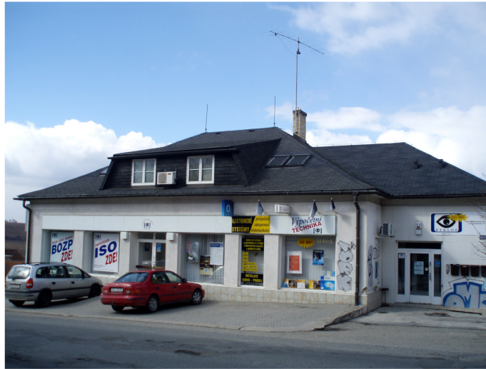
Obr. 16: Prodejna bezpečnostní a výpočetní techniky na místě bývalé samoobsluhy potravin (foto: autor).
